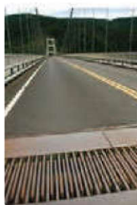
(ب) نمونه‌ای از بست‌های انبساطی
